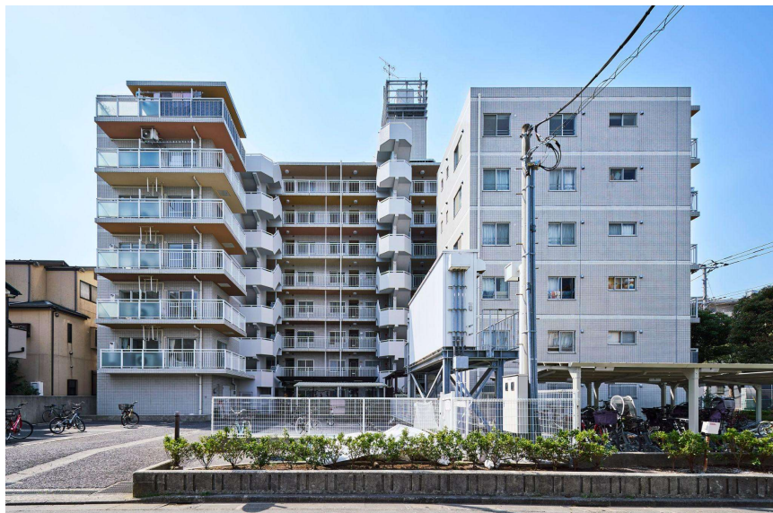
北側外観（撮影：黒岩翼写真事務所）
