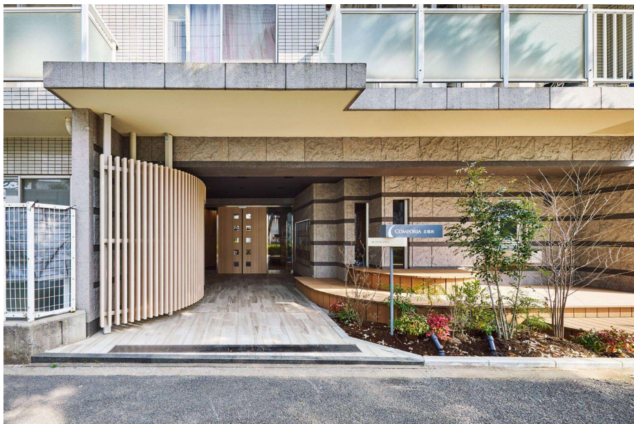
エントランス(after) (撮影：黒岩翼写真事務所)
